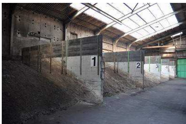
(写真 2) 堆肥化施設の内部
