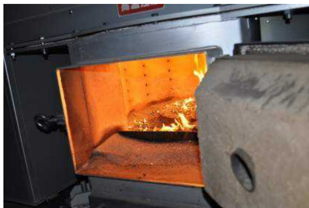
(写真 2) ボイラー内の燃焼の様子
